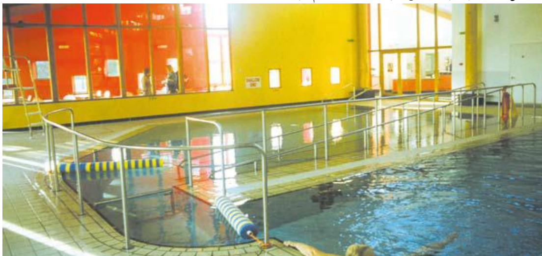
تصویر ۴. وجود رمپ در استخر (۱۲)
